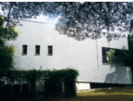
房子西側減少開窗及空氣層設計，阻隔炎夏長時間所產生的高熱。
