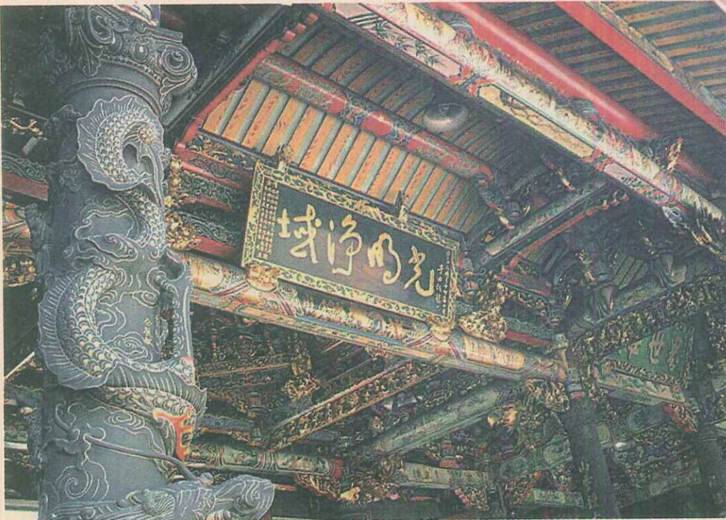
看匾額進歷史隧道，看龍柱是不夠的（社大學員 蔡耀光攝）
